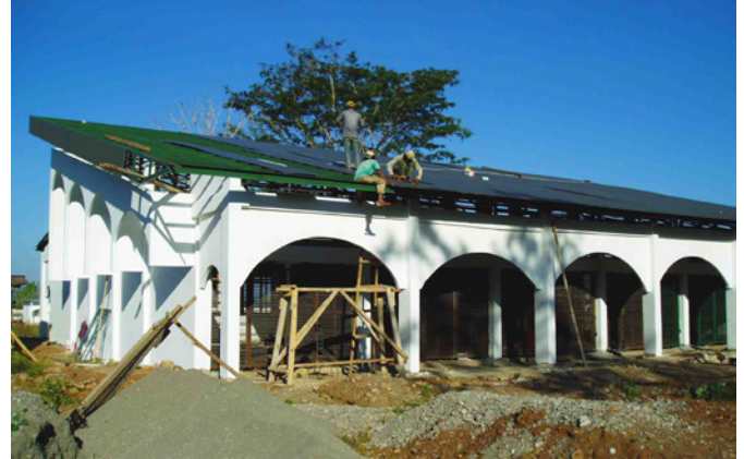
Trabajos de reconstrucción financiados por la AECID en la Escuela Técnica de Maliana, en Timor Oriental. © OTC Indonesia y Timor Oriental
