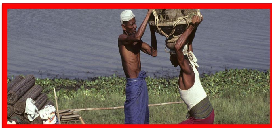
Dos trabajadores bengalíes arrastran trozos de césped durante una excavación.
