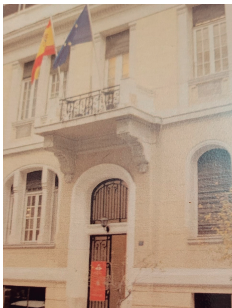
Fuente: Elena Colitto. Fachada de la antigua Legación de España en Atenas y actual Instituto Cervantes.
