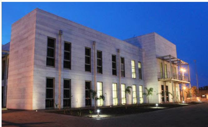
Imagen del nuevo edificio de la Embajada de España en Malabo, inaugurado en julio de 2011. © EFE
