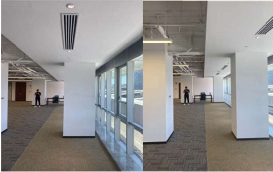
照片17和18：大厅。在房间左侧的东立面。可见一块大理段隔开与玻璃幕墙的连接。吊顶可见回形栅栏出风口。照片 18 可见大厅钢梁和装置。
