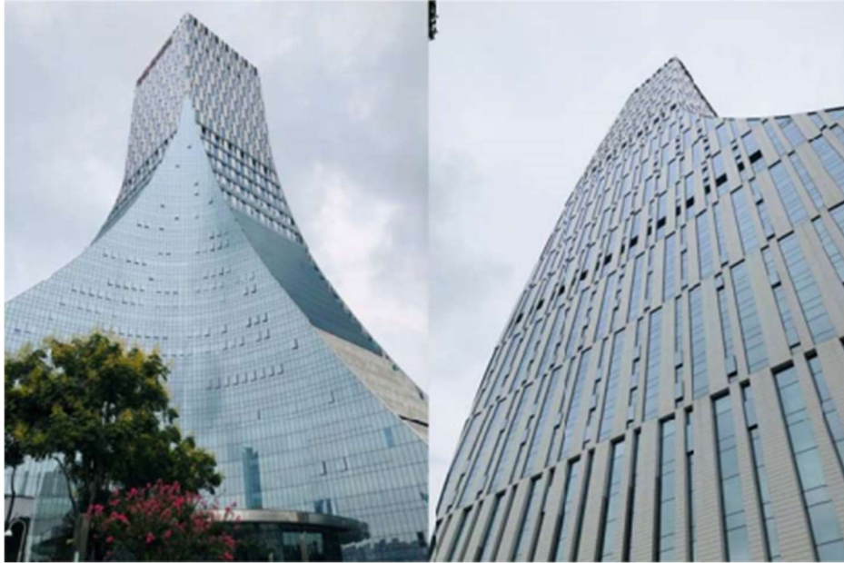
照片1和2：大楼立面
