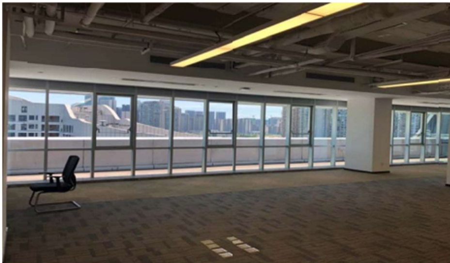
照片 2： 面向东面玻璃立面的中厅
