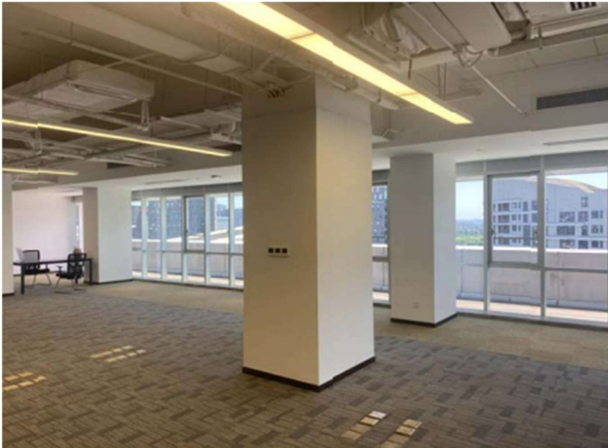
照片10：大厅。石膏板立柱，内有装置。
