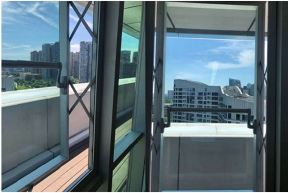
照片22和23：玻璃幕墙推拉窗。前推拉。没有防蚊纱窗。没有窗帘，可打开的窗户占玻璃总面积10-15%。
