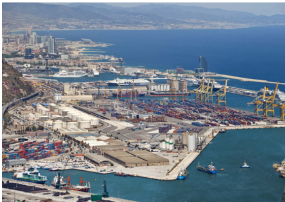
(Barcelona 18-05-2015). La ampliación del Puerto de Barcelona ha sido financiada parcialmente con fondos europeos. © R. Vilalta
