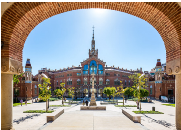
(Barcelona 23-10-2014). La rehabilitación del Hospital de la Santa Creu i Sant Pau contó con financiación del Fondo Europeo de Desarrollo Regional. © R. Ramos / Fundació Privada
