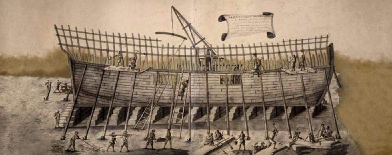
Representación de una fragata en el astillero: forrada hasta la primera cinta, con las planchas de viento, guindola, grúa o pescante para levantar las piezas de gálibo, etc. 1719 - 1739. Diccionario de toda la arquitectura naval moderna. Juan José Navarro de Viana y Búfalo, marqués de la Victoria (1687 - 1772).
