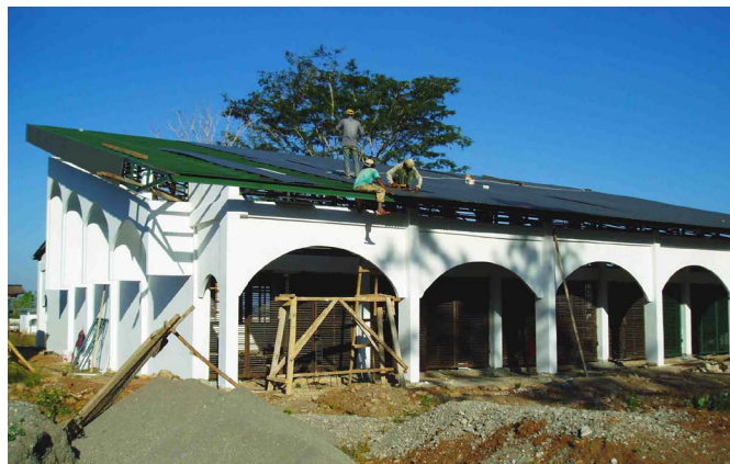
Trabajos de reconstrucción financiados por la AECID en la Escuela Técnica de Maliana, en Timor Oriental. © OTC Indonesia y Timor Oriental
