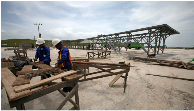
Vista general de las instalaciones financiadas por la Agencia Española de Cooperación Internacional para el Desarrollo en Nicaragua en 2012, que han supuesto el sellado del mayor vertedero de basura habitado en Iberoamérica. © EFE
