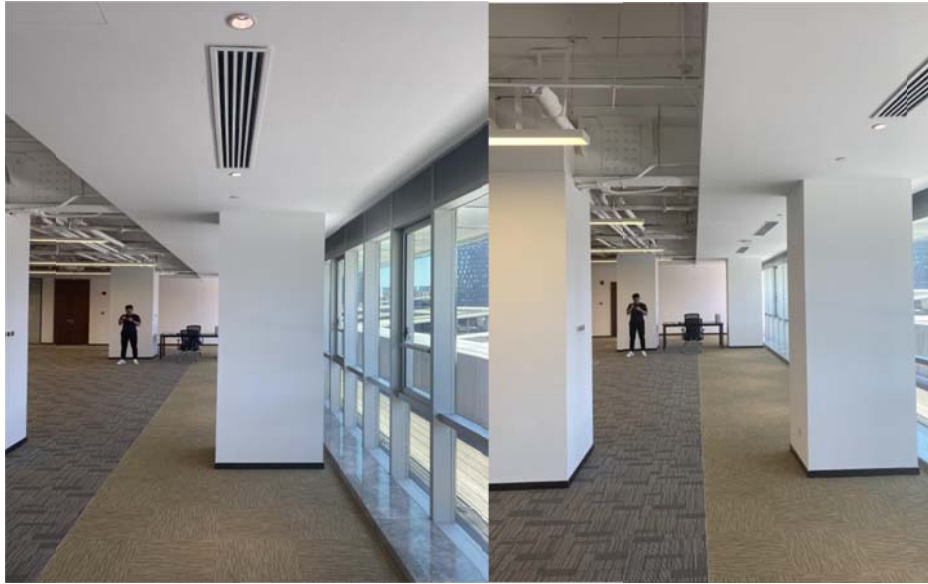
Fotografías 17 y 18 . Sala general. En fachada Este zona izquierda de la sala. Se observa pieza de mármol para resolver encuentro con muro cortina. Se ven rejillas de retorno en el falso techo. Se observa en la foto 18 las vigas de acero y las instalaciones vistas de la sala general.
