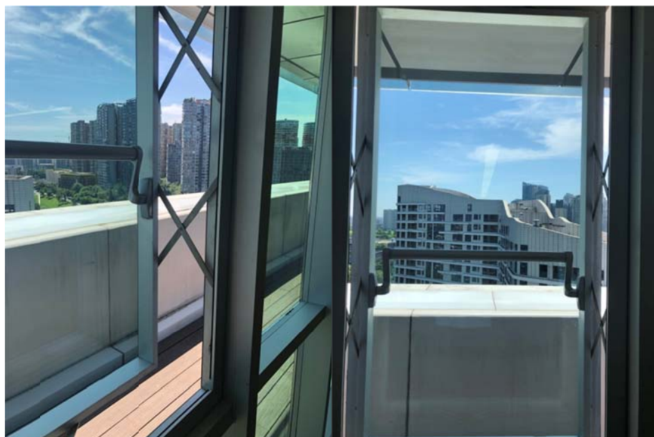
Fotografías 22 y 23. Sistema de apertura de ventanas en muro cortina. Apertura de desplazamiento frontal. No se observan rejillas anti-mosquitos. Tampoco existen cortinajes y el número de ventanas practicables es un 10-15 % de la superficie total acristalada.
