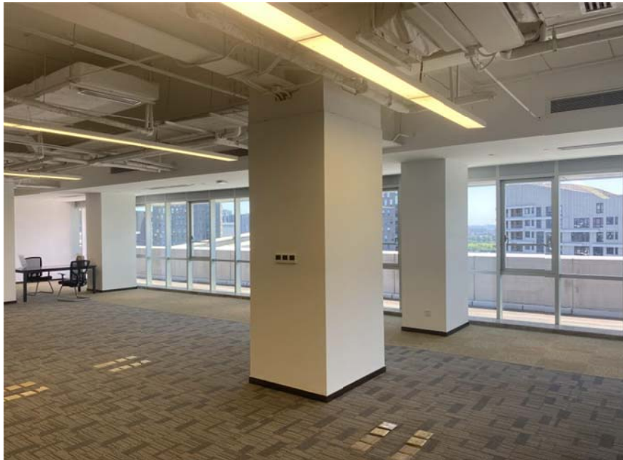
Fotografía 10. Sala general. Pilar cajeado por paneles cartón yeso con instalaciones dentro.
