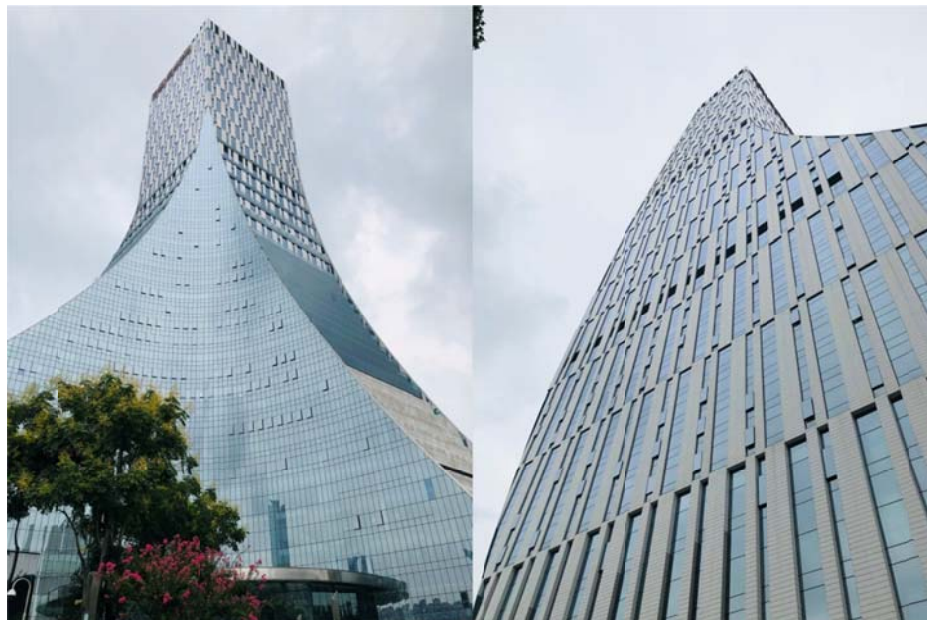
Fotografías 1 y 2. Fachadas del edificio.
